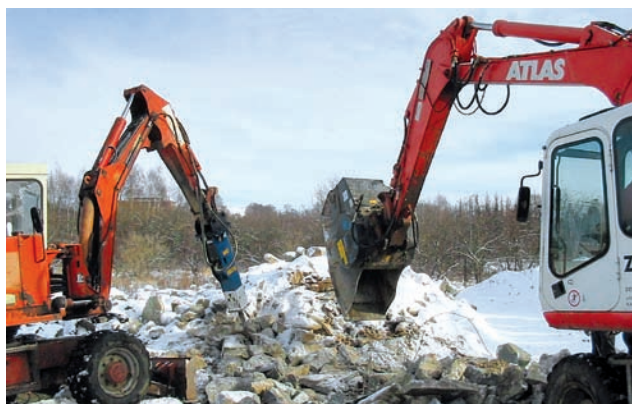
Sestava pro recyklaci: porcování železobetonové sutě kladivem ALL-KOR S 100 a předrcování a haldování drtící lžičky MB BF70.2
