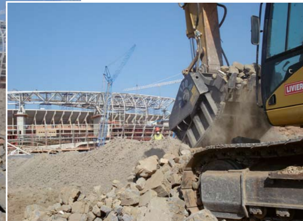
Meccanica Breganzese (MB) produserer fire forskjellige knuseskuffer. Den minste er beregnet for gravemaskiner fra 8 til 14 tonn, mens den største er for gravere over 28 tonn.
